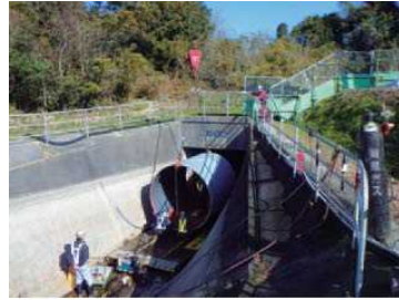
(サイホン内への鋼管の挿入)
