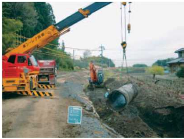
事例:既設水路の更新
