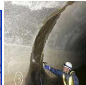
水路トンネル内の調査
