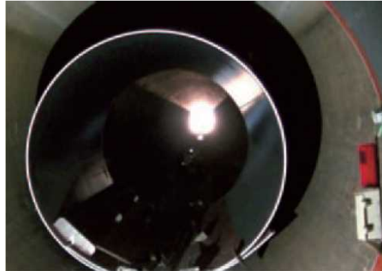
水路内に鋼管を挿入し補強
