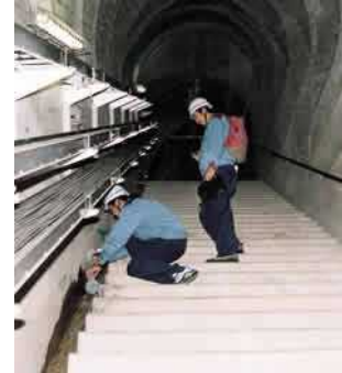
ダム堤体の観測及び施設点検
