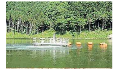
曝気循環設備(大山ダム)
