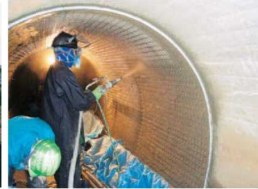
(水路トンネル内面の補強)
