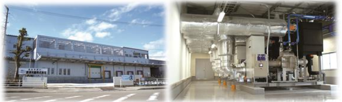
(省エネ自然冷媒冷凍等装置導入事例)
