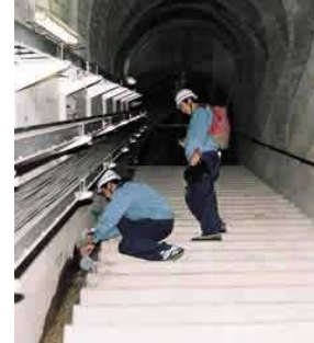
ダム堤体の観測及び施設点検
