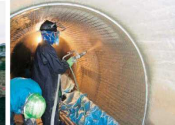
(水路トンネル内面の補強)
