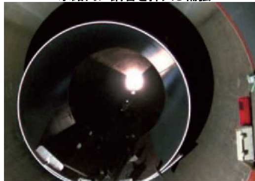
水路内に鋼管を挿入し補強
