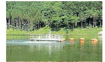
曝気循環設備(大山ダム)
