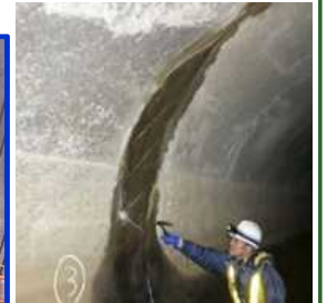
水路トンネル内の調査
