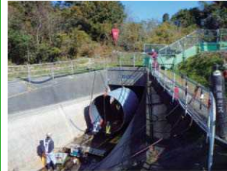
(サイホン内への鋼管の挿入)
