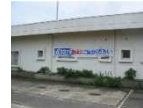
千葉市平川浄水場 出典)北千葉広域水道企業団
