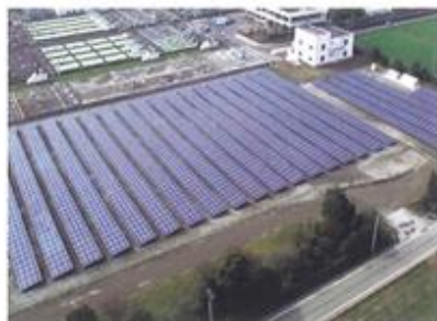
▲0.26kW×3,616枚による毎時最大940.16kW大出力を発電
