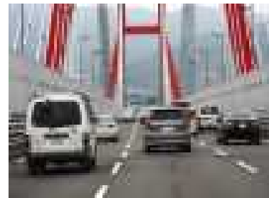
⑦ 六甲大橋北向き
