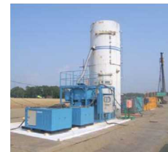
プラント設置状況
