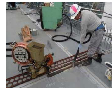
サブマージ溶接
