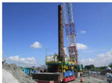
杭建込み状況
