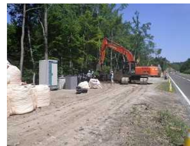
中詰材投入(製作)
