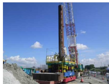
杭建込み状況
