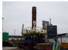
回転圧入状況
