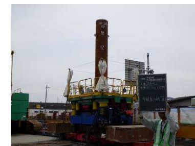
回転圧入状況
