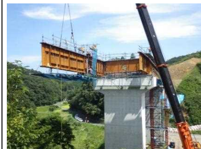
少数I桁架設工
