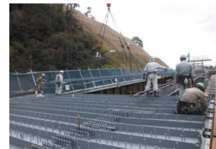
合成床板架設工
