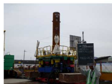
回転圧入状況
