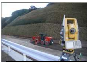
機器設置状況
