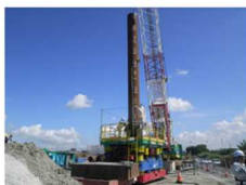
杭建込み状況
