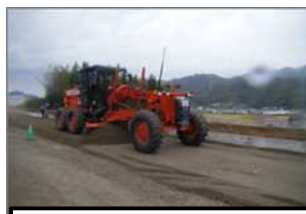
整正作業状況
