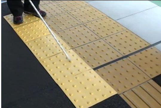
パターン② 開口部前2枚警告ブロック+ 警告ブロック1枚
