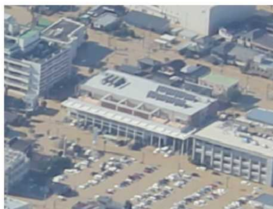
茨城県常総市役所の浸水被害
