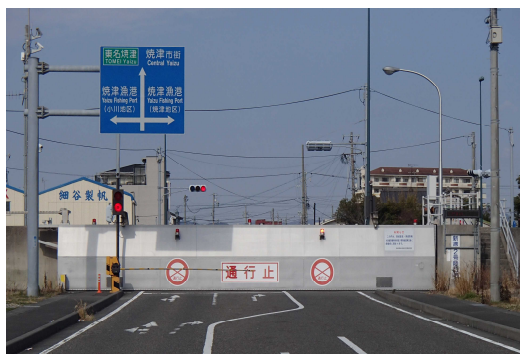
陸閘の設置例 (静岡県焼津漁港海岸)
