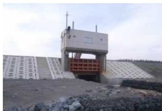
樋門の設置例 (青森県百石海岸)
