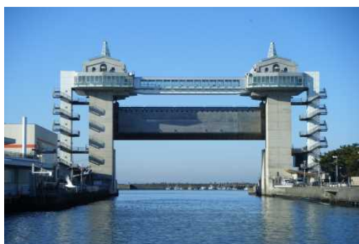
水門の設置例 (静岡県沼津港海岸)
