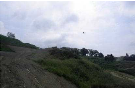
○ UAV(ドローン)による 施工前の測量(9月12日撮影)
