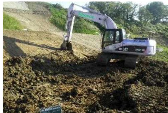
○ ICTバックホウによる法面整形
