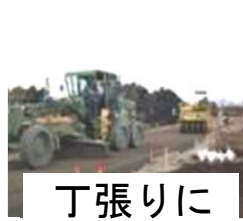
検測と施工を繰 り返して整形
