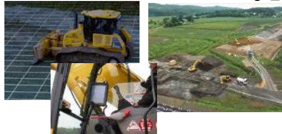
ICT建機での施工
