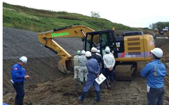
○ ICT技術活用工事現場研修
