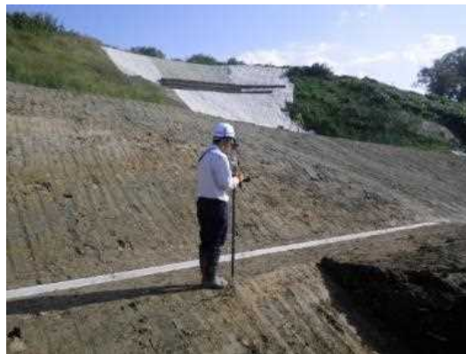
○ 出来形確認の状況
