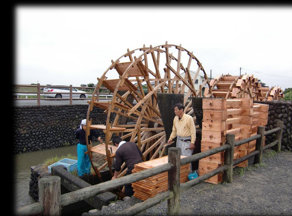
水車の更新作業
