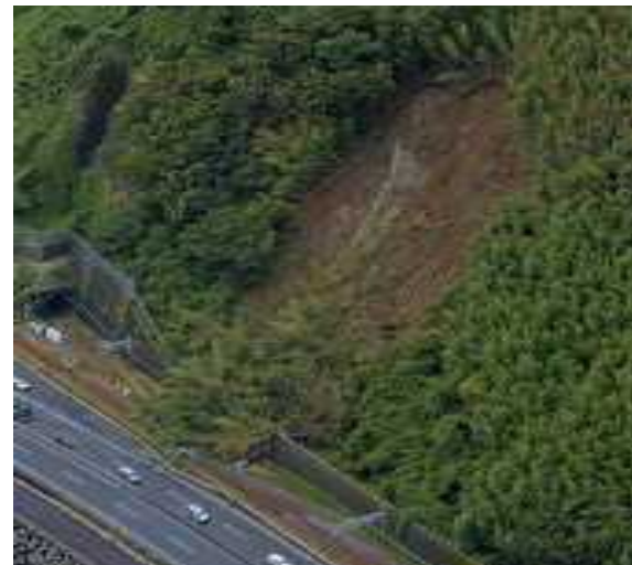
東海道線(由井～興津間)土砂流入
