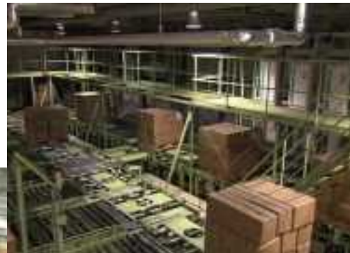
自動ラック倉庫
