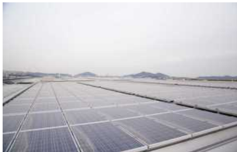
倉庫の屋上に太陽光パネルを設置
