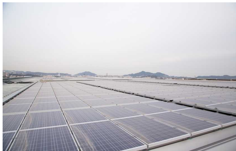
倉庫の屋上に太陽光パネルを設置
