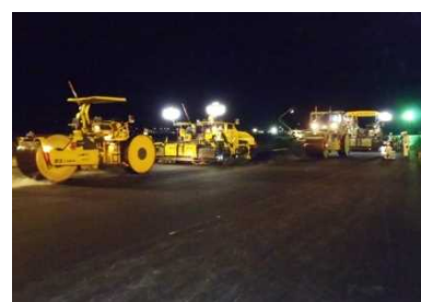
(老朽化した滑走路舗装の改良)
