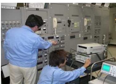
(航空保安施設点検実施状況)
