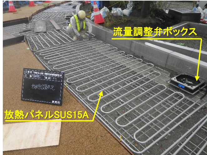
① 放熱パネル(舗装前)
