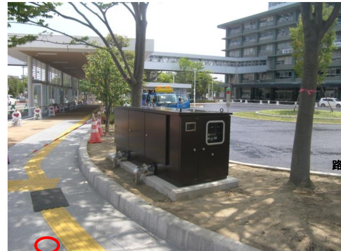
③ 制御盤一体型バルブボックス
