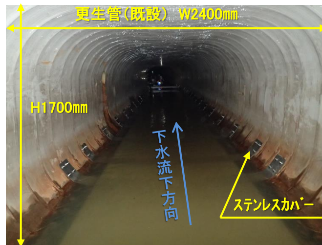
② 採熱管設置完了後
