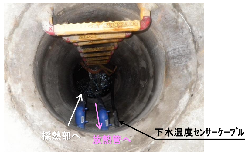
④ マンホール部の配管状況
