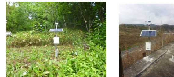
次世代衛星測位システムの設置状況
