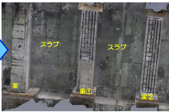
撮影写真より作成した3Dモデル
