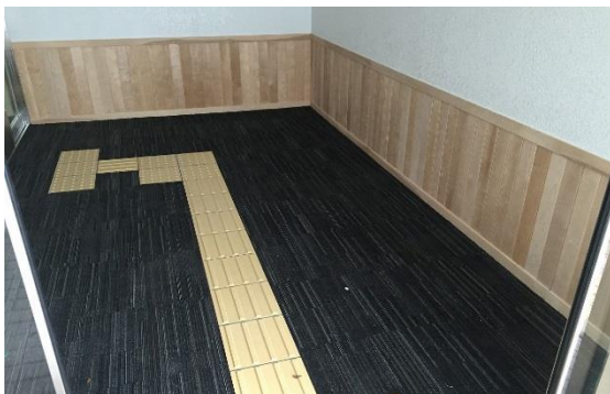
帯広測候所(帯広市)：風除室（腰壁）
