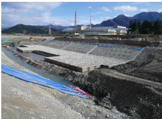
信濃川水系魚野川（新潟県南魚沼市） 『木工沈床』
