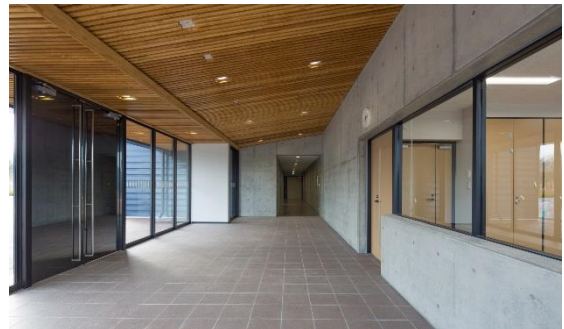
国土地理院 VLBI 観測局舎(石岡市) ：玄関ホール（天井）
