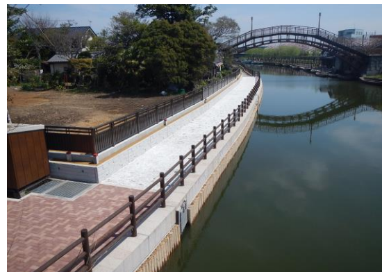
利根川水系前川（茨城県潮来市） 『護岸工、防護柵工』
