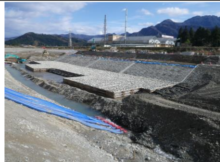
(河川) 信濃川水系魚野川(新潟県南魚沼市) : 木工沈床
