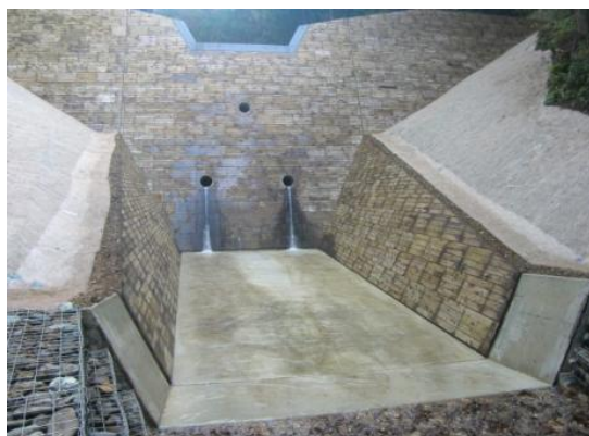
早瀬川水系破風川 （福井県若狭町） 『砂防堰堤（残存型枠）』
