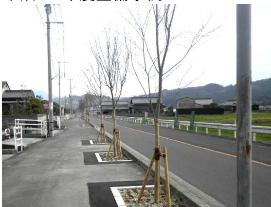
樹木の支柱 福岡県道 453 号 (福岡県大任町)
