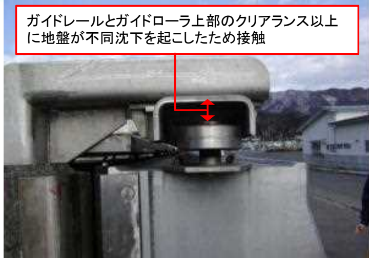
扉体上部のガイドレールとガイドローラの仕組み
