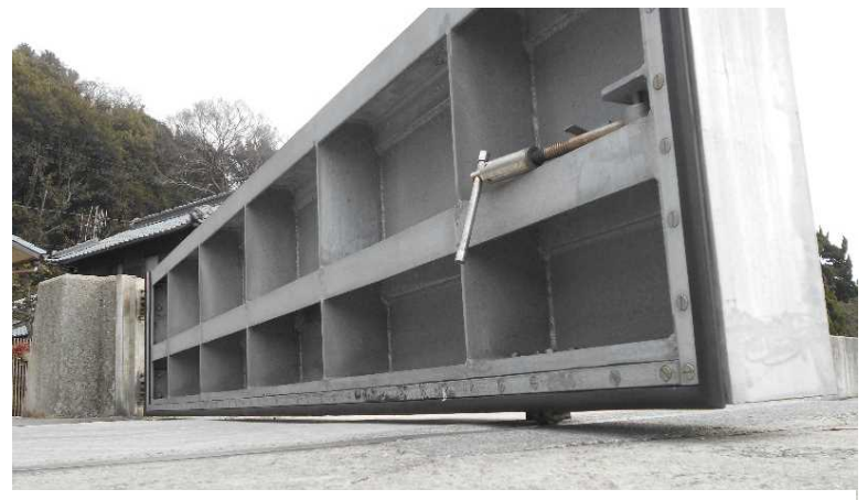
コンクリート床板打ち直し後(陸側より)
