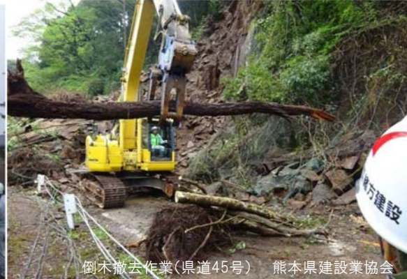
道路啓開作業（益城町） 熊本県建設業協会
