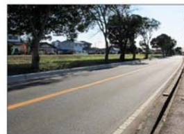
緑石設置完了
