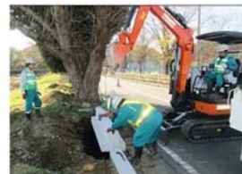
緑石設置作業
