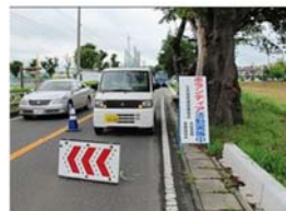
緑石設置工事
