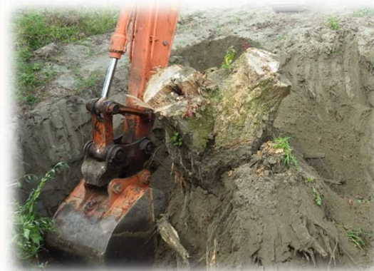
◆根株部分の掘削・撤去
