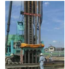
ソイルセメント壁工法 の攪拌状況
