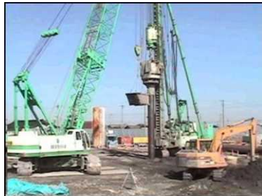
場所打ち杭の施工状況
