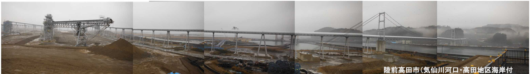
復興事業の状況(ベルトコンベアによる土砂搬出)
