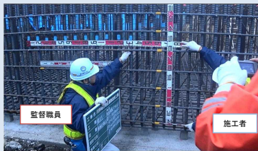
監督職員が現場に臨場して出来形を計測
