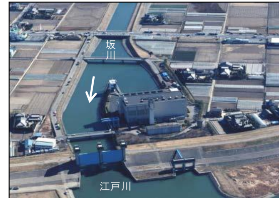
北千葉導水路の稼働により、江戸川へ導水している状況
