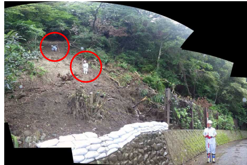
危険な斜面での調査作業
