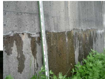
コールドジョイントからの劣化進行例 出典)寒地土木研究所
