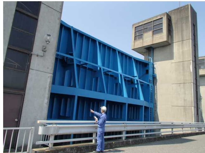
目視による臨時点検 (水門)
