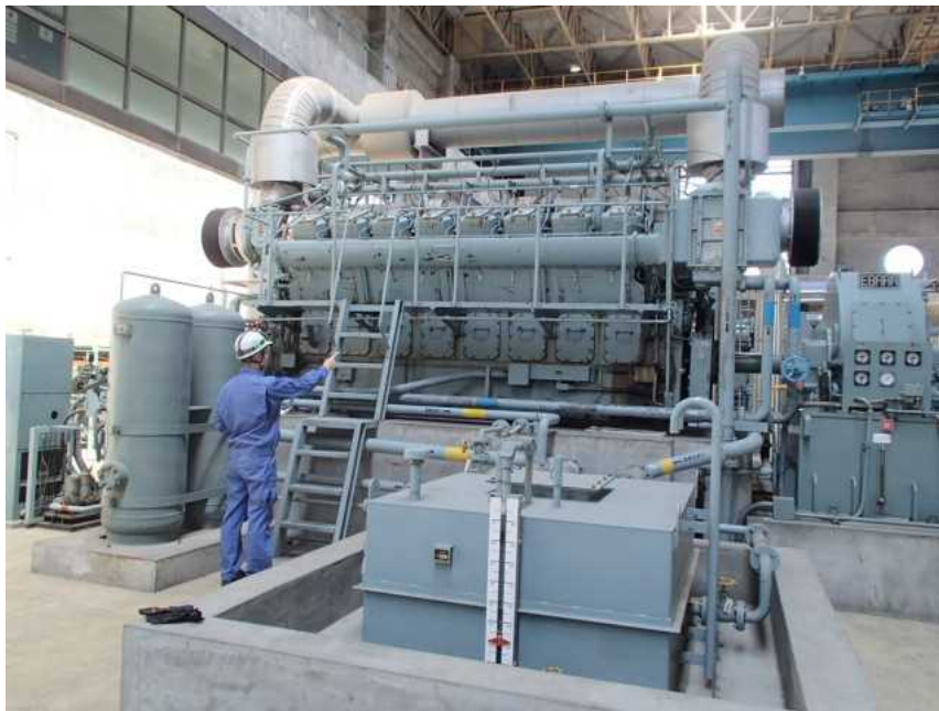
目視による臨時点検 (排水機場ポンプ設備)
