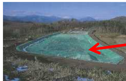
要対策土の処理例: 甲子 かし トンネル(東北地整)
