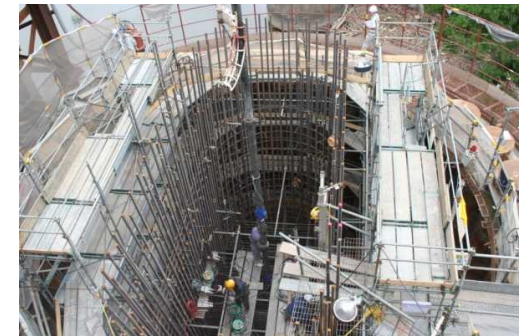
新技術により打設回数を減らした施工事例 →コールドジョイントを予防 出典)北海道開発局
