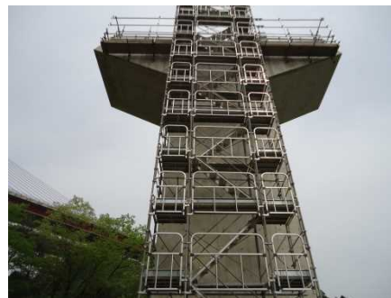
高所での(重)作業
