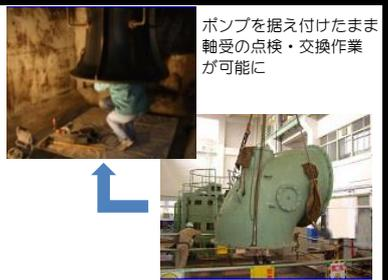
ポンプを据え付けたまま軸受の点検・交換作業が可能に
