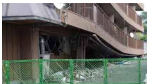
4月16日の本震によって倒壊。1階の柱が複数座屈していた。理事長曰く、座屈の程度が徐々に増しているとのこと。
