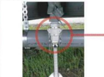
給水管の接続方法が、工具を使わずに着脱できること。
