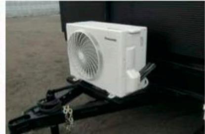
冷暖房器具等の室外機がトレーラーハウスに積載され
