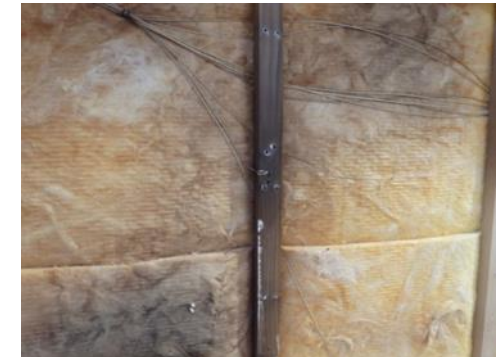
断熱材・野縁表面
