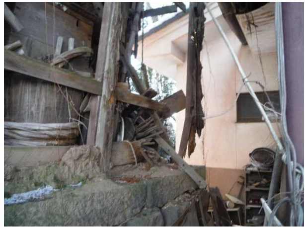
写真3 柱の破損の参考写真（倒壊）
