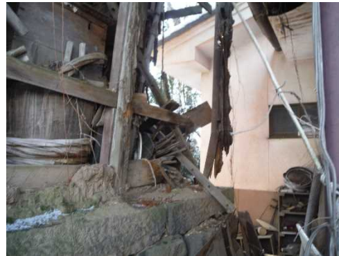
柱の破損等の参考写真
