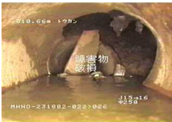
破損した管路
