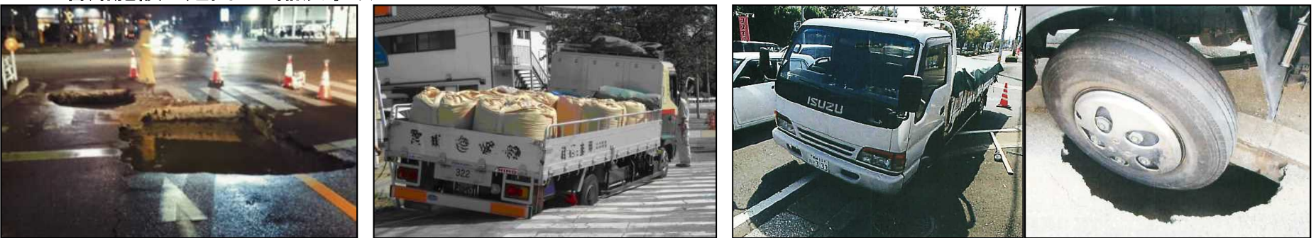
● 管路施設に起因した陥没事故
