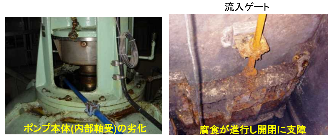
処理場設備の老朽化の例
