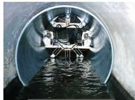
下水道管の再構築
