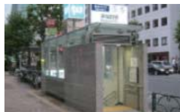
出入口の浸水対策
