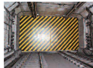
坑口浸水対策 (防水ゲート)
