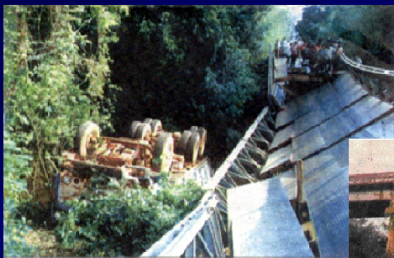
木材運搬車両による橋梁破壊 国道7号線 2004.04.10
