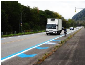
車道への通行位置明示
