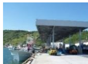
屋根付き岸壁の整備
