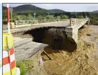
国道38号 太平橋 橋台背面洗掘（南富良野町）
