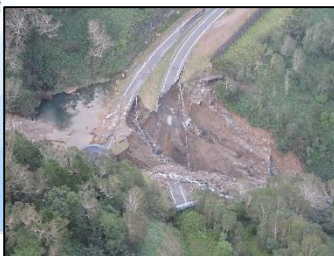
国道274号 日勝峠8号目付近 盛土崩壊（清水町）
