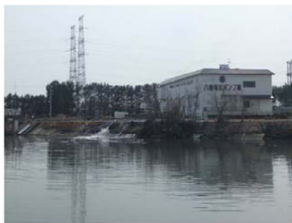
仮設ポンプによる排水
