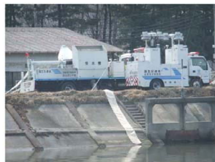
移動ポンプ車による排水
