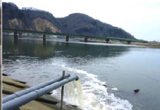
汚水ポンプ場(停止中)付近で簡易沈殿・消毒処理の後、本川まで導水して放流
