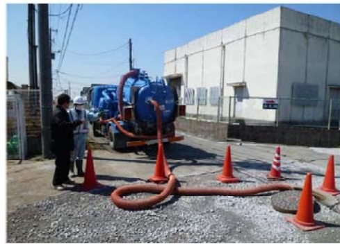
汚泥吸引車による吸引状況
