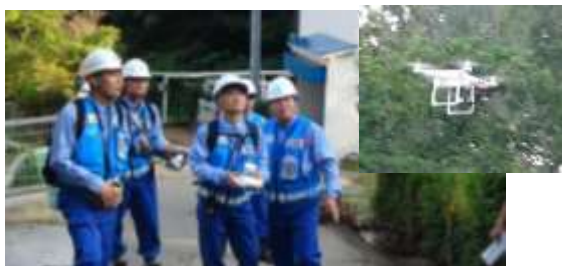
▲UAVによる調査 (資料)中国地方整備局 ※UAV(Unmanned Aerial Vehicle): 無人航空機
