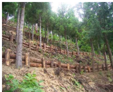
間伐材を活用した山腹保全工
