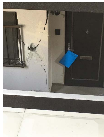
大きな亀裂。ここは引っ越し済
