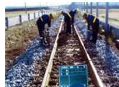
レールの修繕
