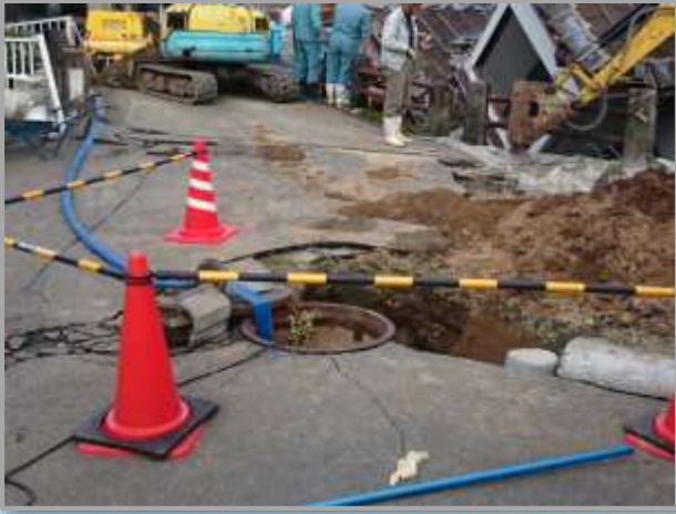
溢水マンホール
