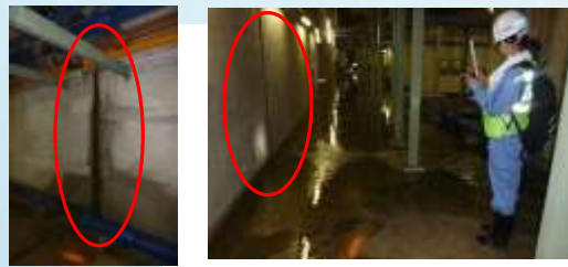
反応タンク躯体の継ぎ目破損
