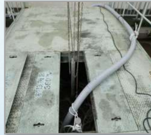
仮設返送ポンプ設置
