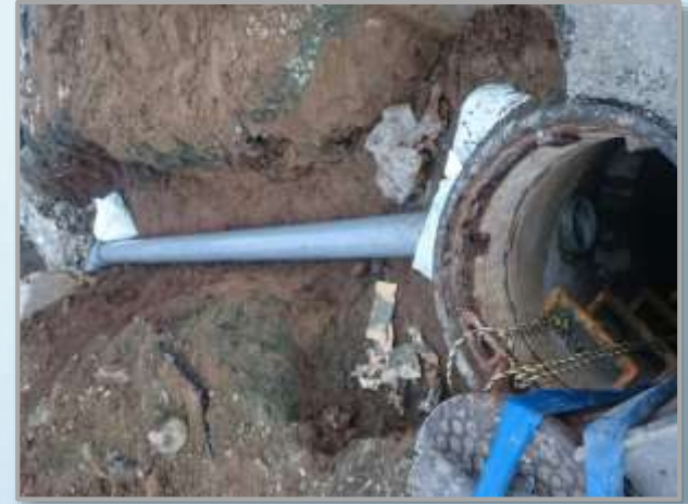
別幹線MHへ仮設管布設
