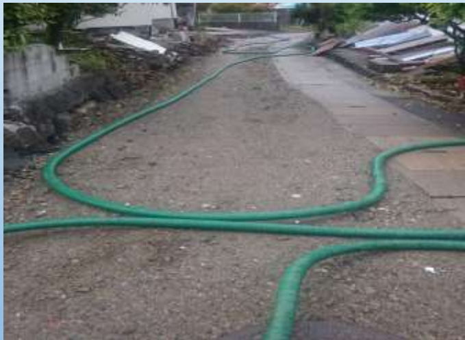
別幹線の正常なマンホールへ
