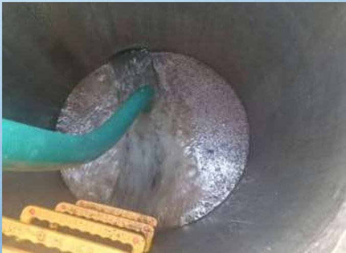
汲み上げた汚水投入
