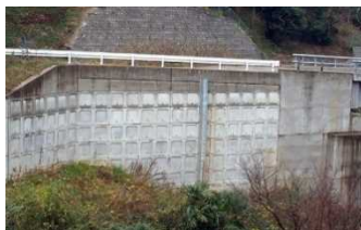
盛土（補強土壁）
