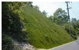
切土（のり面保護）
