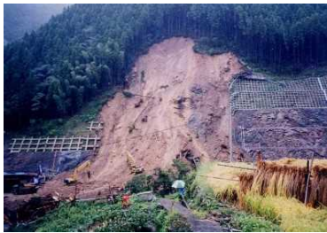
強風化・土砂化斜面での崩壊例
