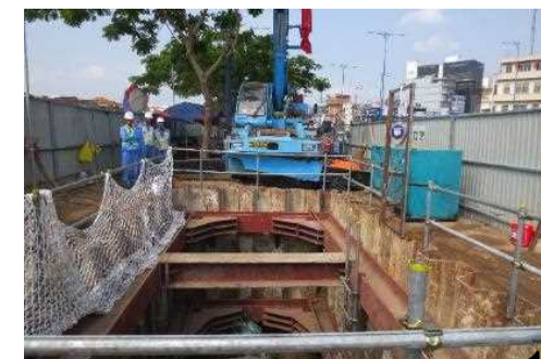
立坑施工の様子(H29.3) (ホーチミン市)
