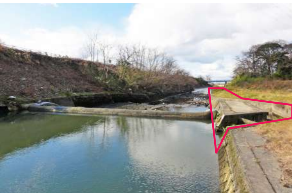
石手川合流前の小野川の河岸に水質浄化材を敷き詰めた浄化施設（写真提供：松山河川国道事務所）
