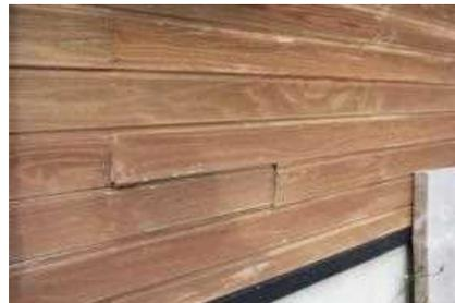
図 5.2 外壁材の反り
