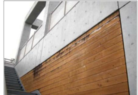
図 12.1 外壁塗装面の汚れ<sup>5)</sup>
