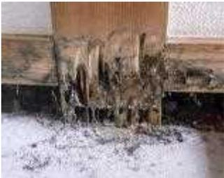
図 2.1 柱脚の被害
