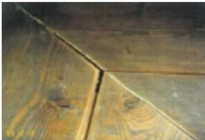
図 5.1 床板の収縮による隙間<sup>2)</sup>
