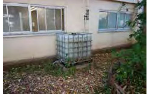
雨水タンク(清進小学校)
