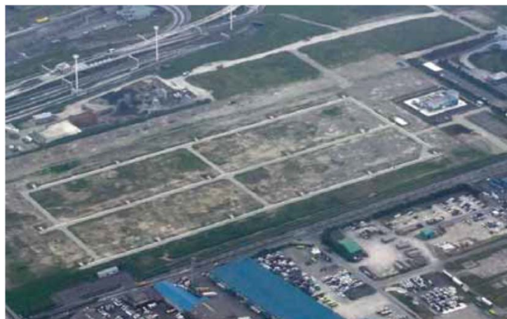
写真-1 浸出液処理施設全景
